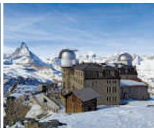
Division Fenster und Türen Hochleistungsfenster von EgoKiefer im Kulmhotel, Zermatt auf 3131 m ü. M.
